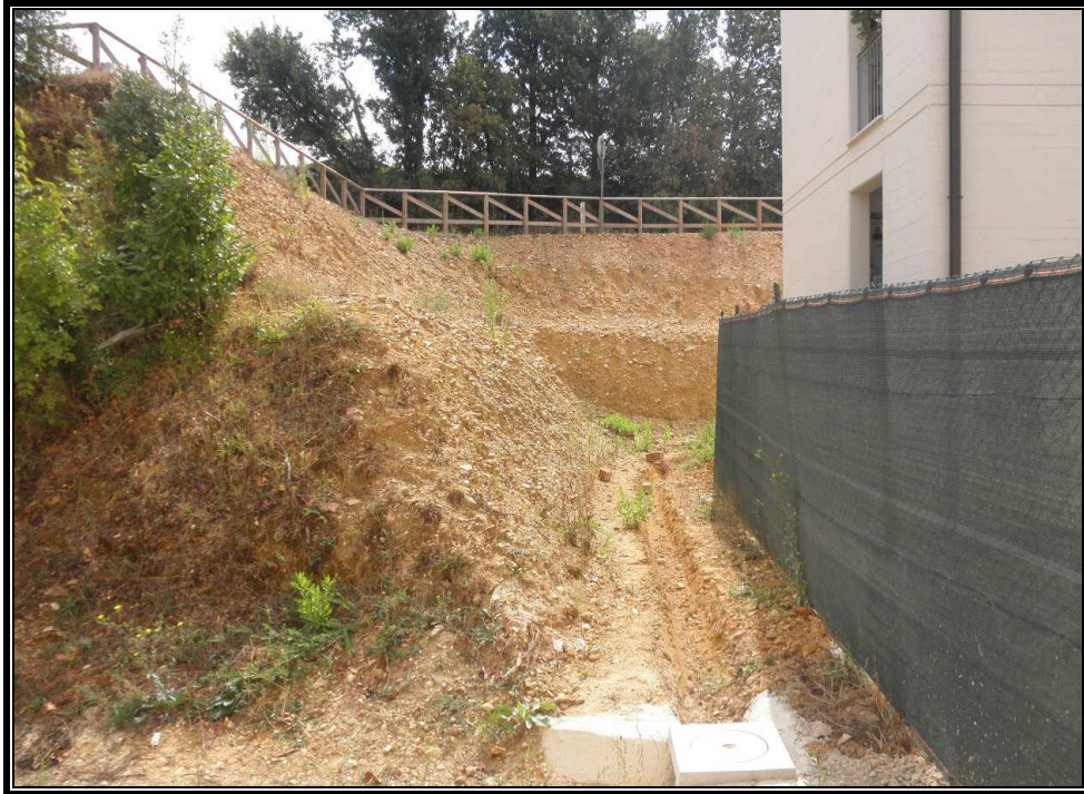
Foto – panoramica fianco laterale dell'intervento recente
